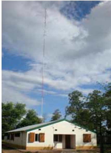
Este es el lugar donde está instalada la planta transmisora en Añatuya.
